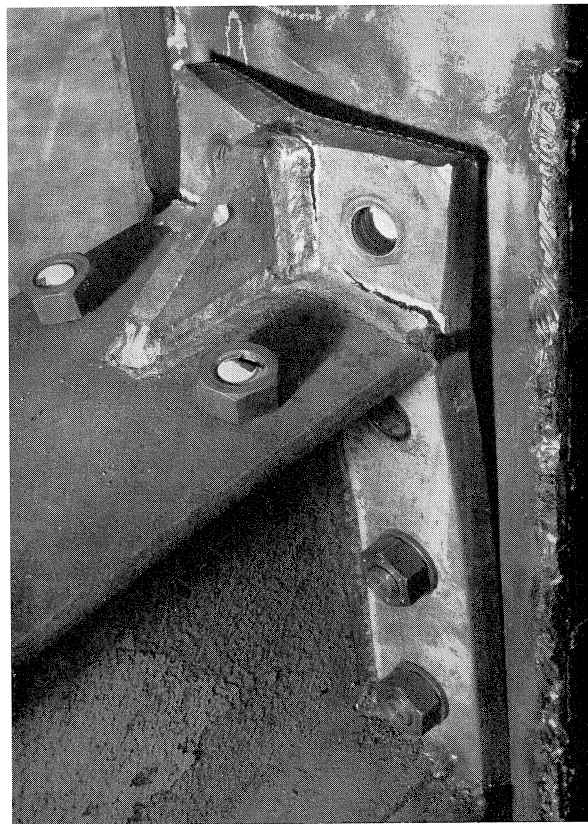
Fig. 9. Tot bezwijken belaste hoekverbinding met voorspanbouts.
