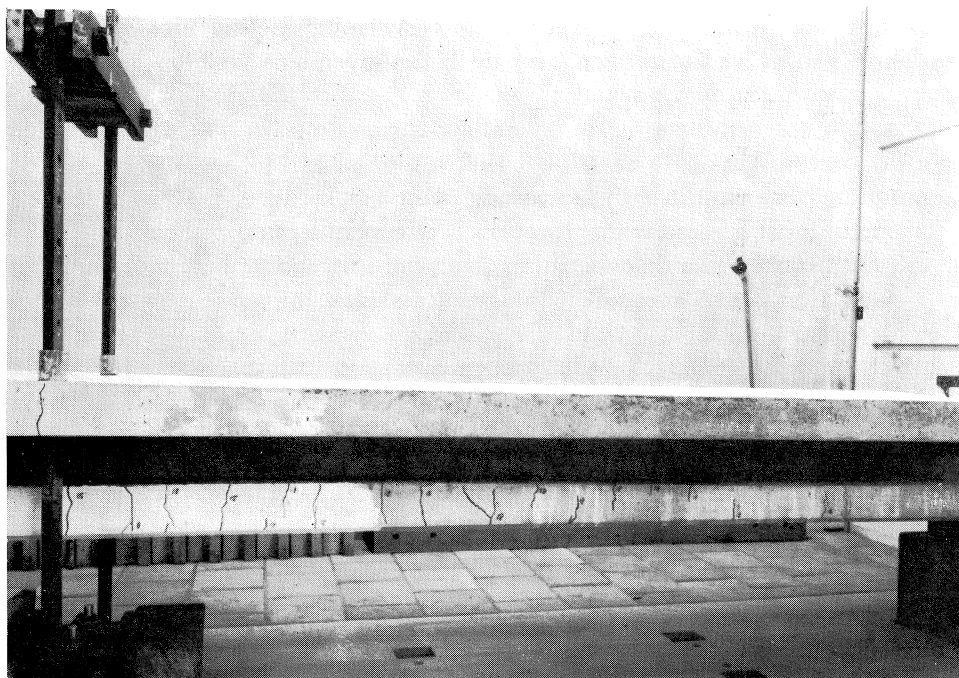
Fig. 15. Scheurenbeeld preflexconstructie in fase 18.
