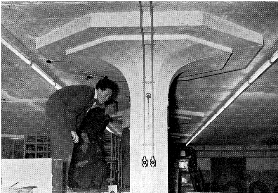
Dezelfde proefbelasting; meting aan de onderzijde
