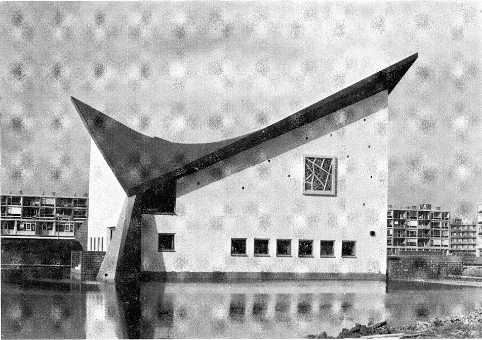
Enkelvoudig hyparschaal-dak op de Paaskerk te Amstelveen
