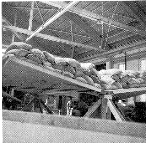
Beproeving van een prototype van een houten hypparschaal
