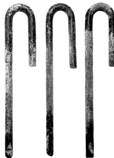
Fig. 1. Uitbreiding van de roestvorming naar weerszijden van de scheuren. (De scheuren waren nabij het boven- en ondereinde dwars op de staafrichting aangebracht).
