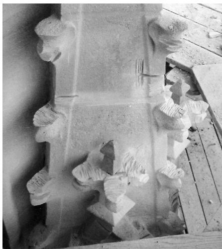
Figure 13: Moulding crockets with Monulit mortar (photo: Architectenburo J. van Stigt b.v.)
